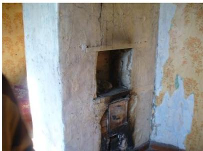
Для отвода дыма следует применять вертикальные дымовые трубы без уступов. В местах пересечения дымовых труб со сгораемыми конструкциями расстояние от внутренней поверхности дымовых каналов до этих конструкций должно быть не менее 38 см.
