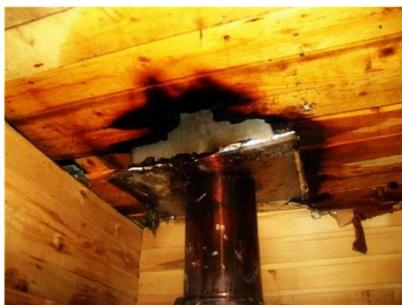
Во-первых, нарушение правил устройства печи: недостаточные разделки дымовых труб в местах их прохождения через деревянные перекрытия, а также малые отступки - расстояния между стенками печи и деревянными конструкциями перегородок и стен дома; отсутствие предтопочного листа. Под печь возводится самостоятельный фундамент.
